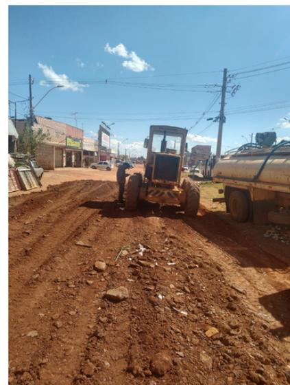
**Terraplanagem com o uso de fresado no Trecho III**
