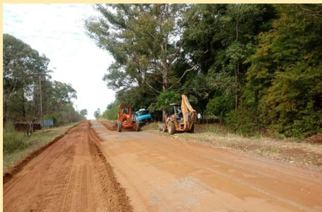
Na zona rural, patrolamento e ajustes em oito quilômetros de estrada de terra na DF 249, via que dá acesso ao Paranoá, Rota do Cavalo. O serviço incluiu construção de saídas de águas pluviais e limpeza de bacias de contenção e construção de novas bacias. Melhorias foram feitas no acesso à Escola Classe Santa Helena, um preparo para o retorno das aulas.
