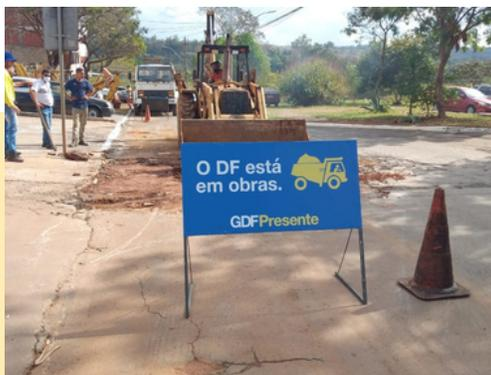
Na Avenida Sucupira, nas proximidades da QS 10, um quebra-molas irregular foi removido e nova lombada foi construída. As placas de sinalização vertical, que alertam os condutores de veículos sobre a presença da lombada, foram instaladas.
