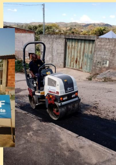
**Após o trabalho de requadramento de buracos, limpeza e preparo para recapeamento, 10 toneladas de massa asfáltica foram usadas na subida da Expansão do Engenho Velho.**
